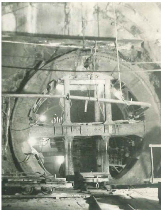
A 2-es metró alagútépítése nyílt homlokú pajzsokkal. Átmérője 5,50 m. beérkezése a Baross téri pajzskamrába. Munkatér 1,6 ~ 1,8 at. túlnyomás alatt
