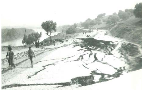
A suvadás, lezökkenés kiterjedése, az út teljes tönkremenetele
