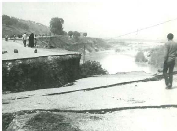
A mozgó talajtömeg lezökkenése és mozgása a folyómeder felé
