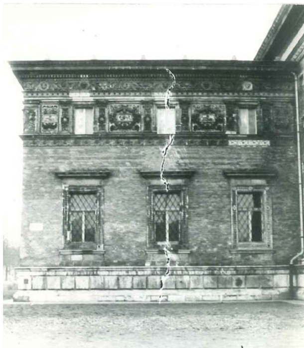
A Budapesti Múcsarnok egyik szárnyának teljes átrepedése egyenlőtlen süllyedés következtében
